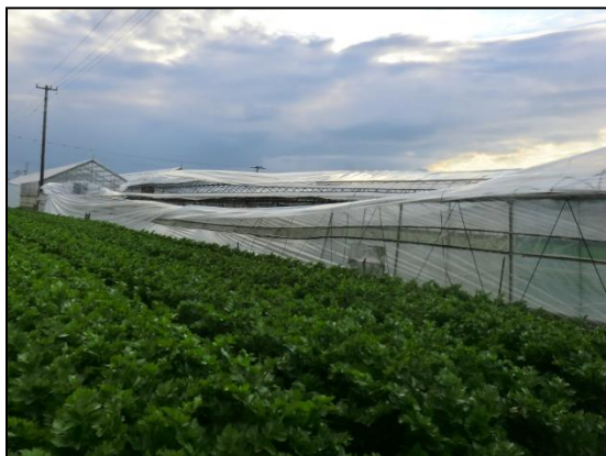
写真①鋼管(管径25mm)が変形した パイプハウス (北東方向から撮影)
