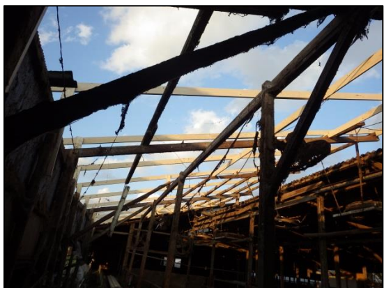
写真③屋根ふき材が飛散した木造 の畜産施設
