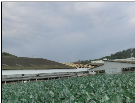
写真②屋根ふき材が飛散した木造 の畜産施設 (北西方向から撮影)
