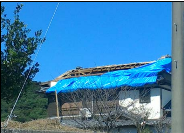
写真③ 屋根の野地板が飛散した住家 (南方向から撮影)
