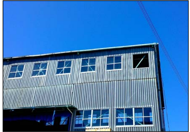
写真② 窓ガラスが破損した鉄骨倉庫 (南方向から撮影)
