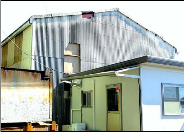
写真① 外壁が破損した鉄骨倉庫 (南西方向から撮影)
