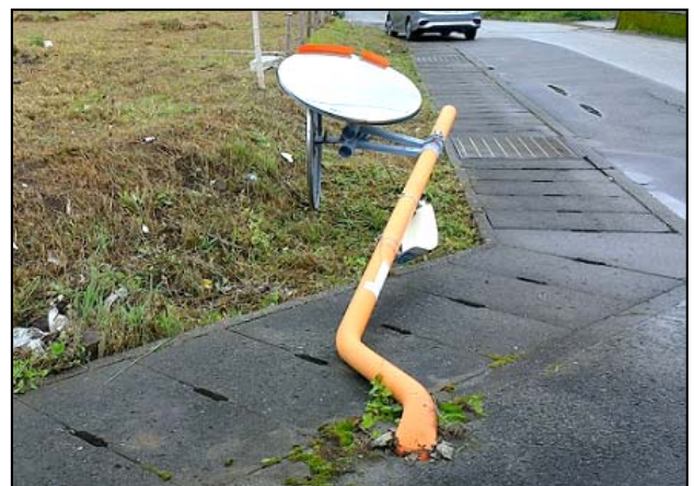
写真⑥ 支柱が折れ曲がったカーブミラー (南西方向から撮影)
