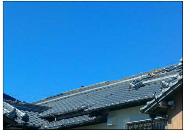
写真④ 屋根瓦が飛散した住家 (南東方向から撮影)
