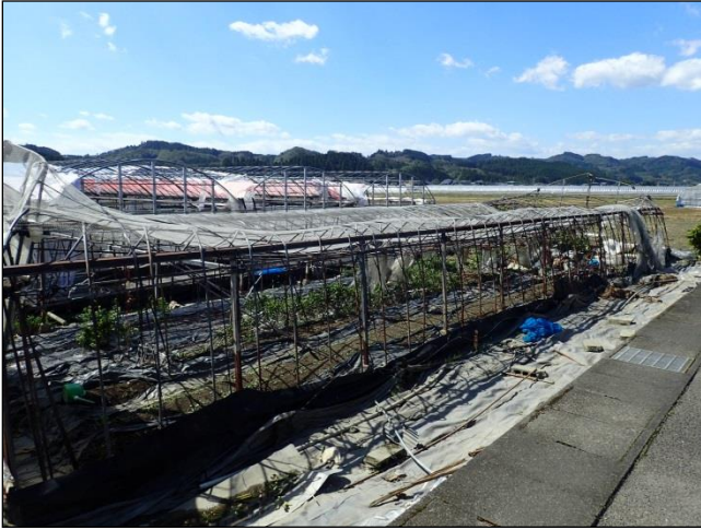
⑬パイプハウスの鋼管の変形
