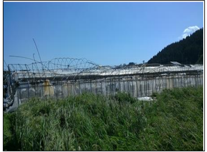
⑯パイプハウスの鋼管の変形
