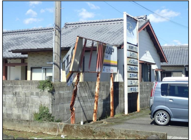
⑫看板の破損
