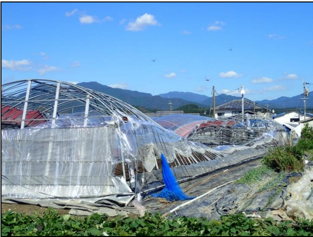
⑮パイプハウスの倒壊
