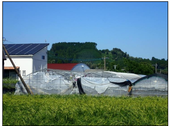
④パイプハウスのビニールのめくれ
