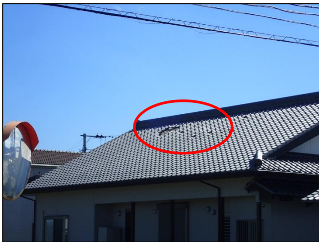
③屋根瓦のめくれ
