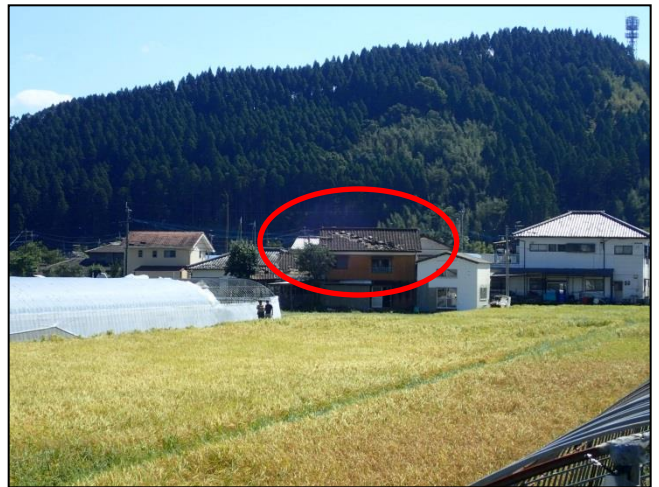
⑧屋根瓦のめくれ。
