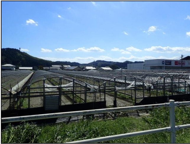
⑦パイプハウスのビニールのめくれ
