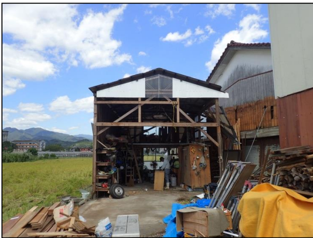
⑨倉庫のトタン壁破壊
