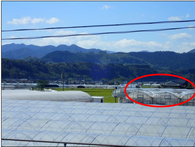
①パイプハウスのビニールのめくれ
