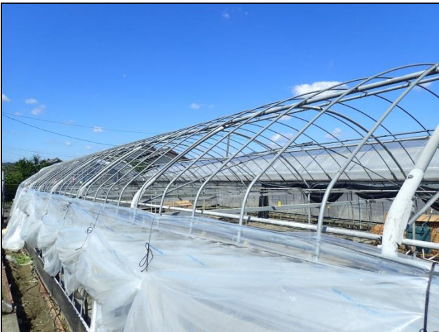
⑰パイプハウスのビニールのめくれ
