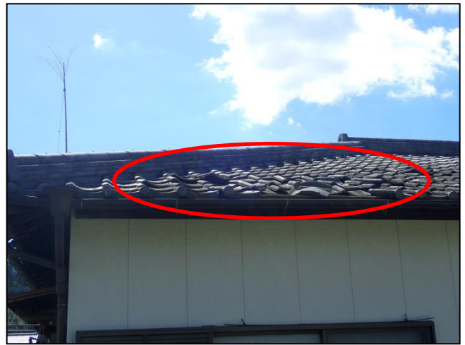
⑩屋根瓦のめくれ
