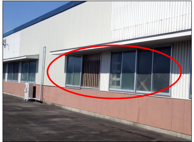
②窓ガラスの破損(修復済み)
