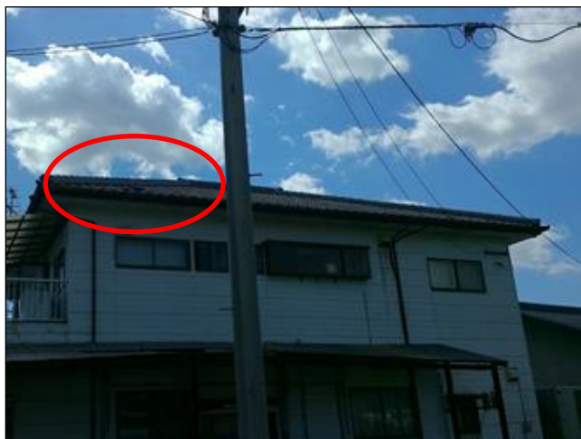
⑪屋根瓦のめくれ
