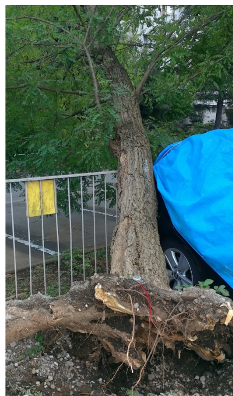
④ 根返りした樹木 (北東方向から撮影)
