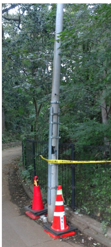
③ 折れた電柱 (南方向から撮影)
