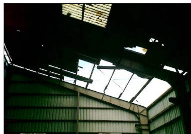
写真⑤ 屋根ふき材が飛散した倉庫
