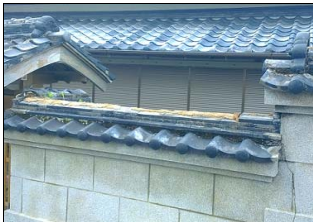
写真② 塀瓦がはく離した住家(南東方向から撮影)
