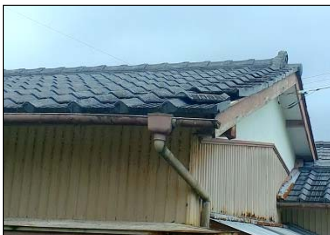
写真③ 屋根瓦が浮き上がった住家(東方向から撮影)
