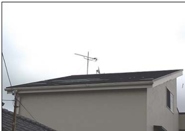
写真① 比較的狭い範囲でスレート瓦が飛散した住家(北西方向から撮影)
