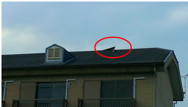
屋根の一部が破損した住家 【南方向から撮影】
