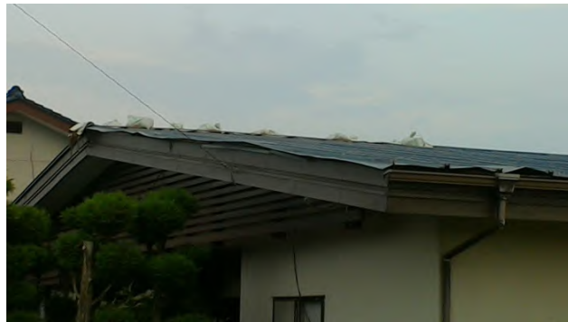
屋根のトタンがめくれた住家 (補修済み) 【南西方向から撮影】
