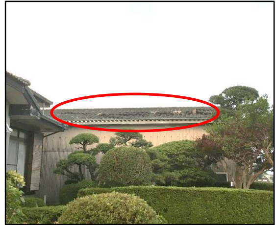
①-2屋根瓦が一部めくれた非住家 【大木町役場提供】
