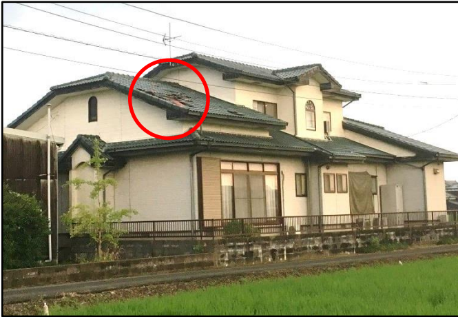
①-1屋根瓦が一部めくれた住家 【大木町役場提供】
