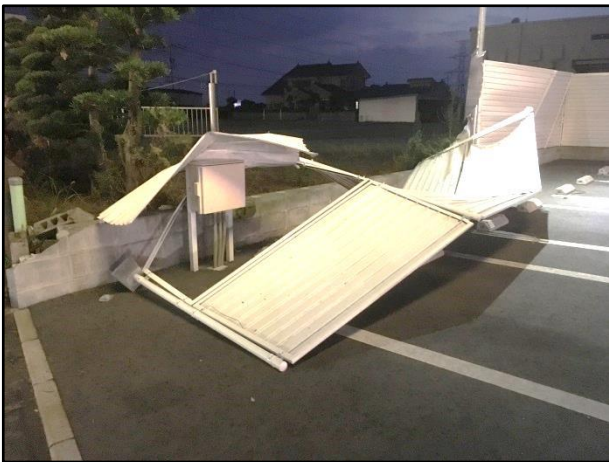
②一部損壊したフェンス 【大木町役場提供】
