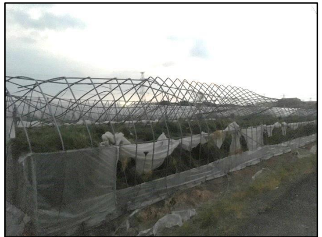
③鋼管の変形と被覆材がはく離した パイプハウス（ビニールハウス） 【大木町役場提供】
