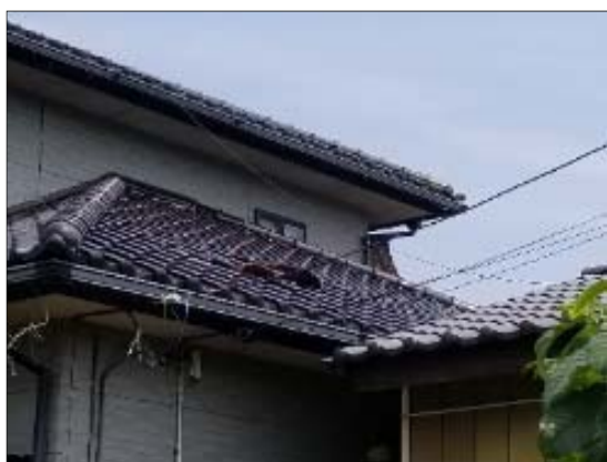
③ 屋根瓦がめくれた住家 (北西方向から撮影)
