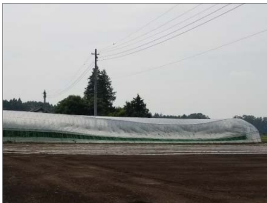
① 銅管が変形した農業用ハウス (東方向から撮影)
