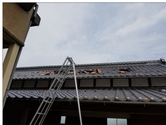
② 屋根瓦がめくれた住家 (西方向から撮影)
