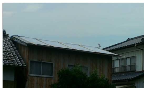
⑤ 屋根のトタンが飛散した非住家 (飛散箇所を修繕済み 南東方向から撮影)
