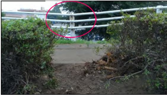
根元から折れた樹木で曲がった ガードレール【東方向から撮影】
