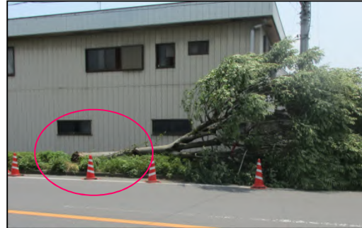
根元から折れた樹木 【北方向から撮影】
