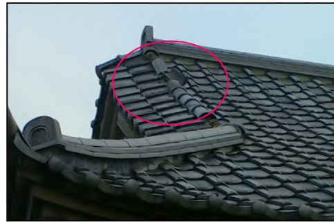
瓦がめくれた住家 【南方向から撮影】
