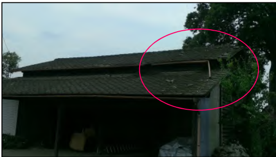
瓦がめくれた非住家 【北方向から撮影】
