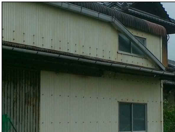
写真④雨どいが破損した倉庫 (北西方向から撮影)
