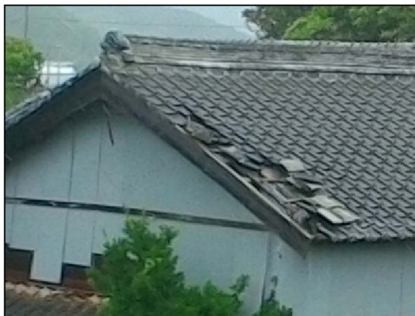
写真②屋根瓦が飛散した非住家 (南東方向から撮影)
