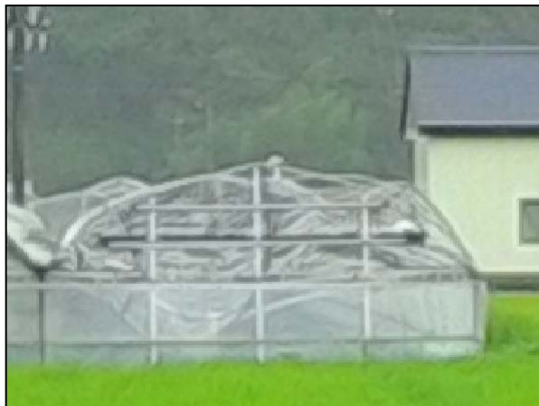
写真⑦鋼管(直径20mm)が変形した パイプハウス(南方向から撮影)
