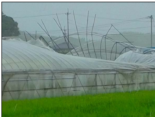
写真⑪鋼管(直径25mm)が変形した パイプハウス(北西方向から撮影)
