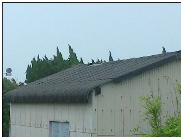
写真①屋根ふき材が破損した鉄骨造倉庫 (西方向から撮影)
