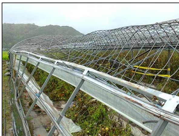
写真⑧鋼管(直径20mm)が変形した パイプハウス(南方向から撮影)
