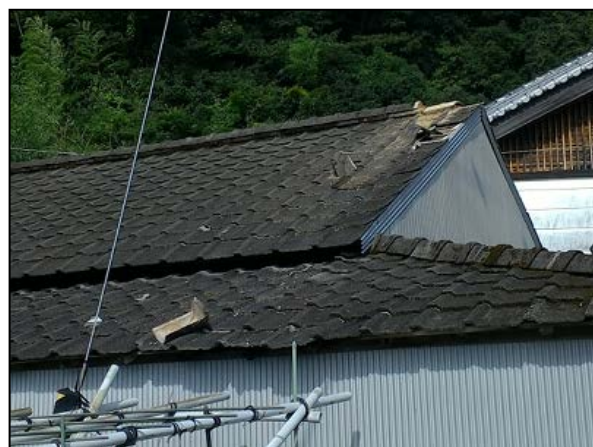
写真⑫屋根瓦が飛散した住家 (西方向から撮影)
