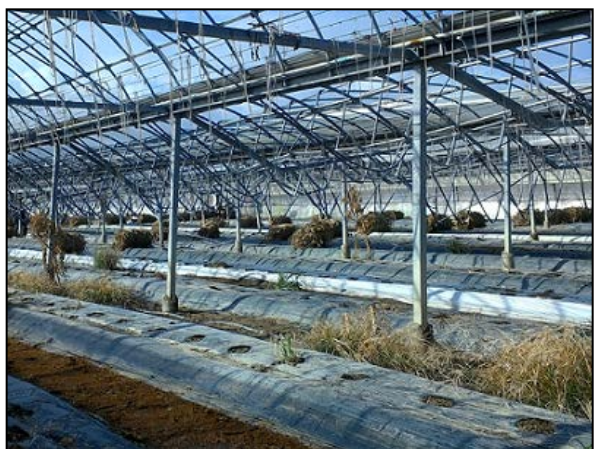
写真⑨鋼管(直径27mm)が変形した パイプハウス
