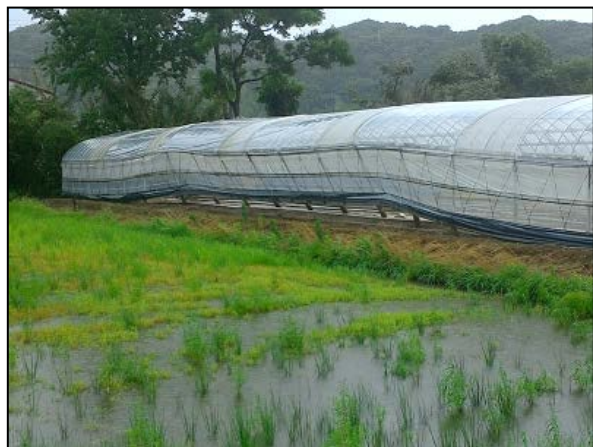
写真⑩鋼管(直径25mm)が変形した パイプハウス(南西方向から撮影)
