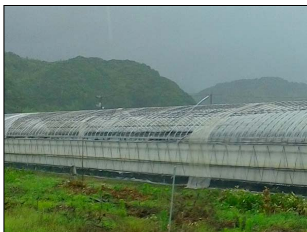
写真⑤被覆材がはく離したパイプハウス (南方向から撮影)
