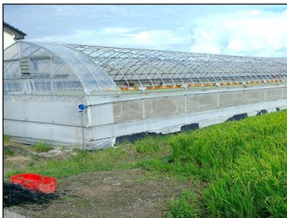
写真⑥被覆材がはく離したパイプハウス (北西方向から撮影)
