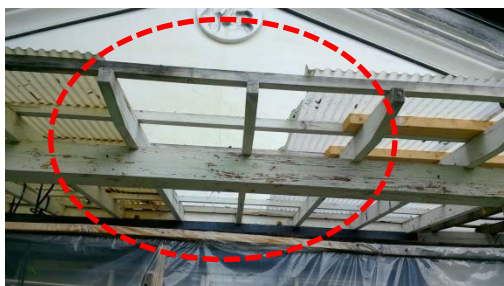
③木造非住家の庇の破損
