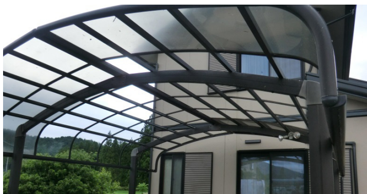
③ 屋根パネルの破損したカーポート (北から撮影)
