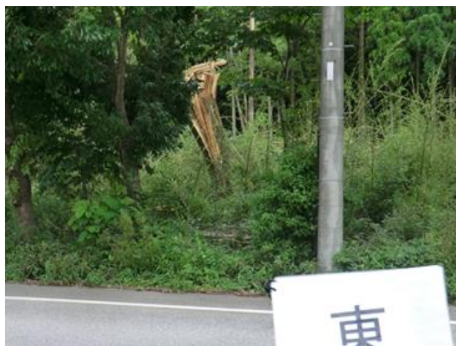
② 幹折れした樹木 (西から撮影)
