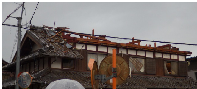
⑤ 小屋組の構成部材が飛散した住宅 (北東から撮影)
