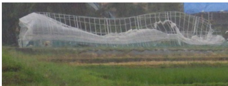
⑥ 鋼管の変形したパイプハウス (西から撮影)
