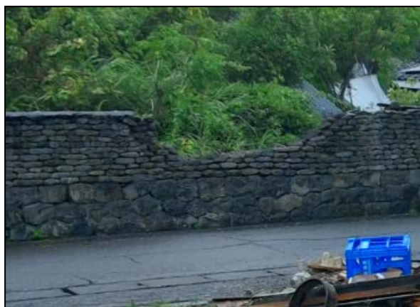
写真③飛ばされた車庫がぶつかった衝撃 で壊れた塀(撮影方向:南西)
