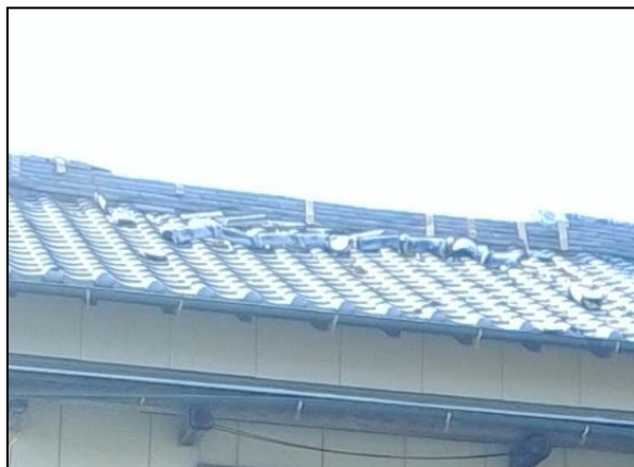
写真②屋根瓦が飛散した住家 (撮影方向:南東)
