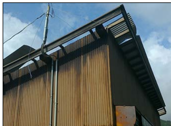
写真④屋根ふき材がめくれた車庫 (撮影方向:南西)
