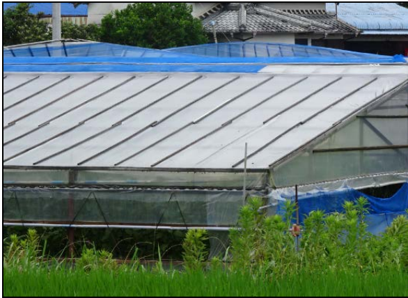
写真⑨被覆材がはく離したパイプハウス (撮影方向:西)
