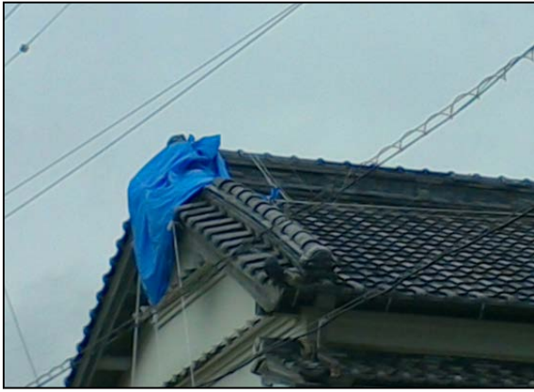
写真⑦屋根瓦が飛散した住家 (撮影方向:南西)
