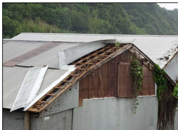
写真⑤屋根ふき材がめくれた倉庫 (撮影方向:北西)
