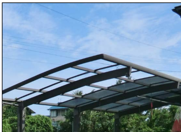
写真①屋根パネルが飛散したカーポート (撮影方向:北)
