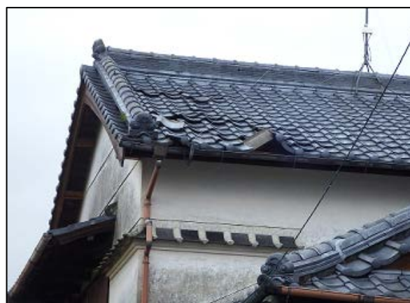
写真⑥屋根瓦がめくれた住家 (撮影方向:南)
