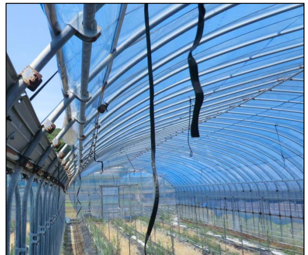
写真④ 鋼管の変形したパイプハウス (③のハウスを中から撮影)
