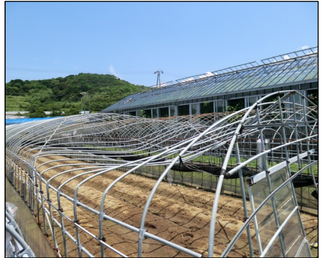
写真② 鋼管の変形したパイプハウス
