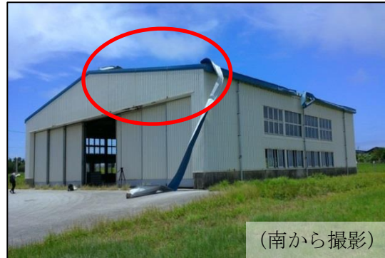
②-1 屋根ふき材がめくれた空港格納庫
