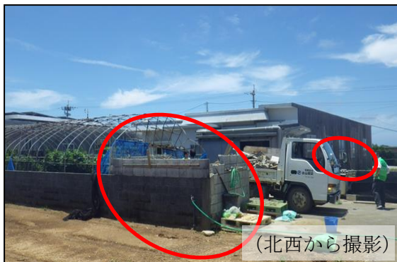
⑬ 作業小屋の屋根飛散、飛散物による窓ガラス破損
