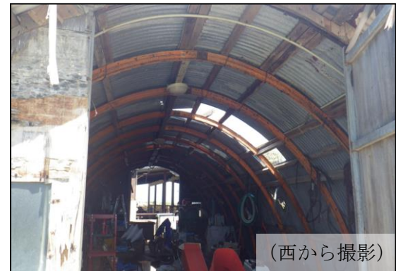
⑩ トタン屋根の剥がれ
