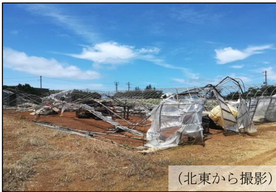
⑧-1 ビニールハウスの倒壊（西へ倒壊）
