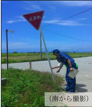
① 道路交通標識の傾倒
