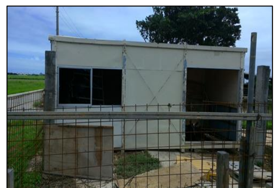
⑪-2 横転したコンテナ（復旧後）
