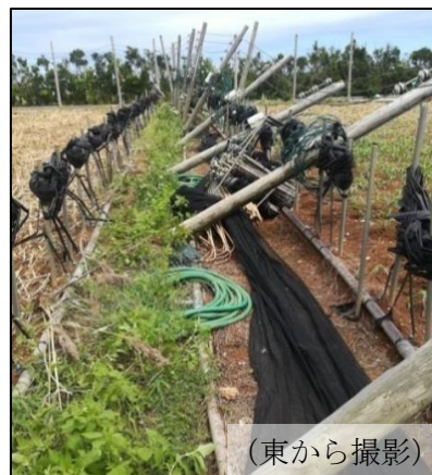
⑦ 木製柱の折損・傾倒 (北に倒伏)
