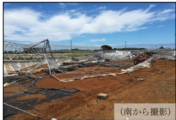
⑧-2 ビニールハウスの倒壊
