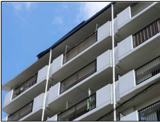
写真 スレート屋根が飛散した住家
