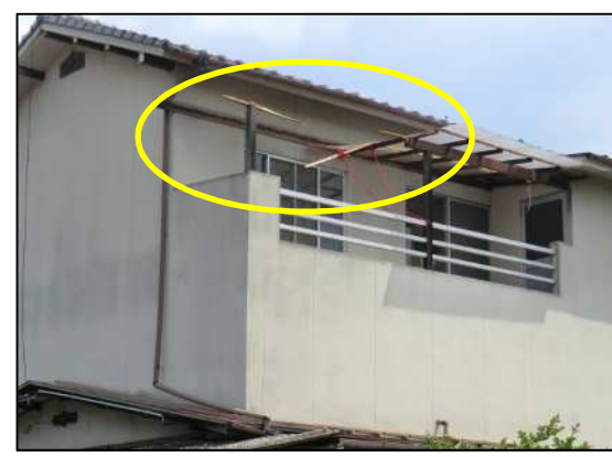
写真 破損した2階ベランダの ポリカーボネートプレートの 屋根
