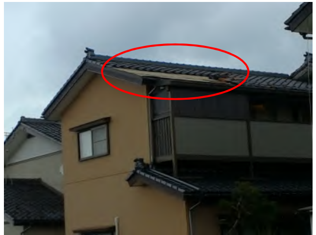
屋根瓦のめくれや落下があった住家 【南西方向から撮影】
