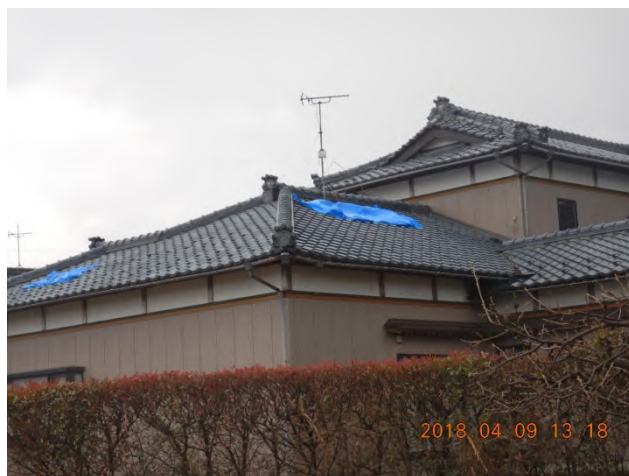
屋根瓦のめくれや落下があった住家 【北西方向から撮影】
