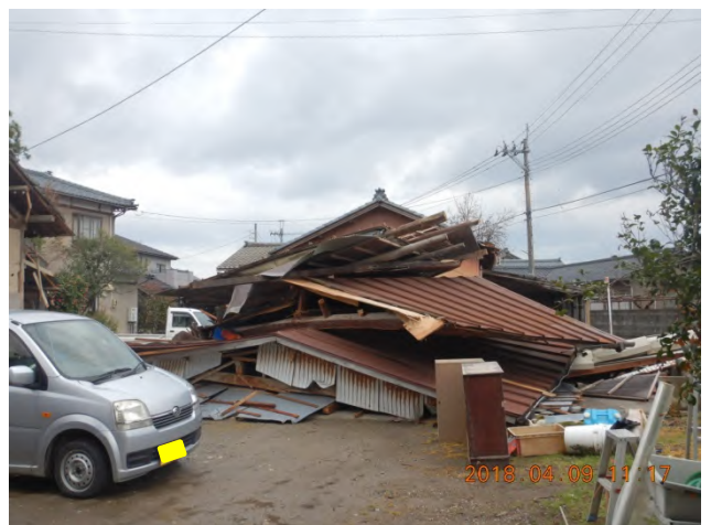
倒壊した非住家 【南方向から撮影】
