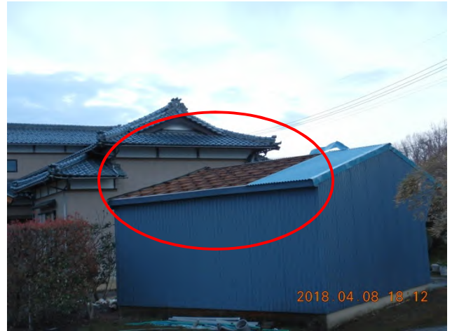
屋根のトタンが飛散した非住家 【北西方向から撮影】
