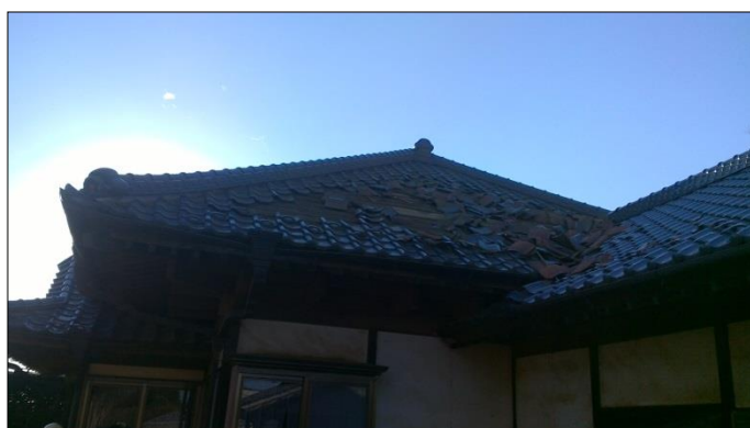
⑤ 屋根瓦がめくれた住家 (東から撮影)
