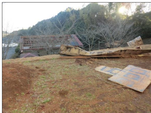
③ 屋根のトタンが飛散した非住家 (北東から撮影)
