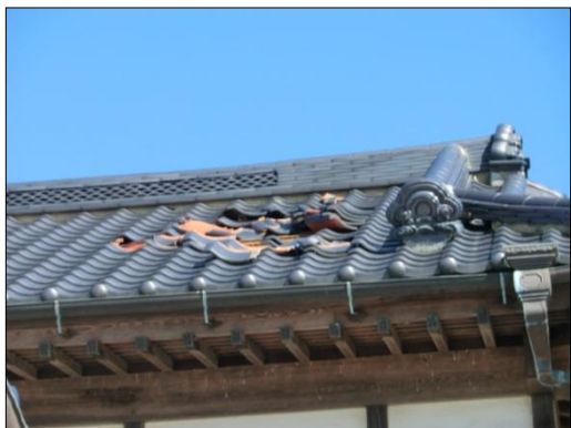
① 屋根瓦がめくれた住家 (西から撮影)
