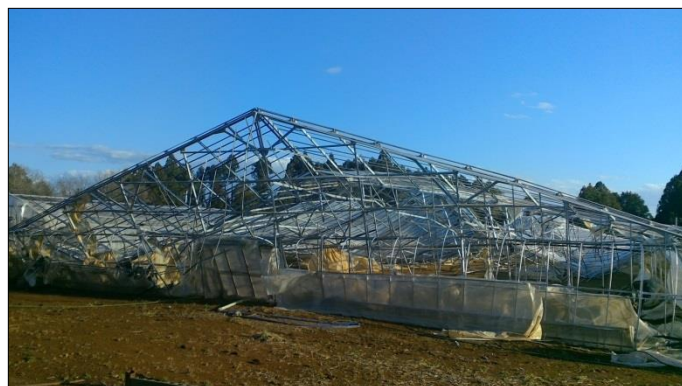
④ 構造部材が変形した農業用ハウス (北から撮影)
