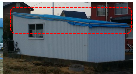
⑧木造物置の屋根の飛散 (物置の屋根が北に約120~130m飛散した。)
