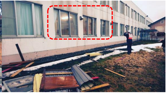
②飛散物による窓ガラスの損壊 (むかわ町役場提供)
