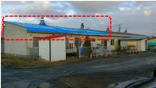
⑤木造の集合住宅の屋根のトタンののはく離又は飛散
