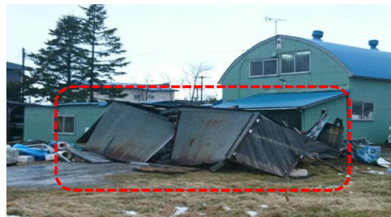
⑦木造の非住家建築物の倒壊 (むかわ町役場提供)
