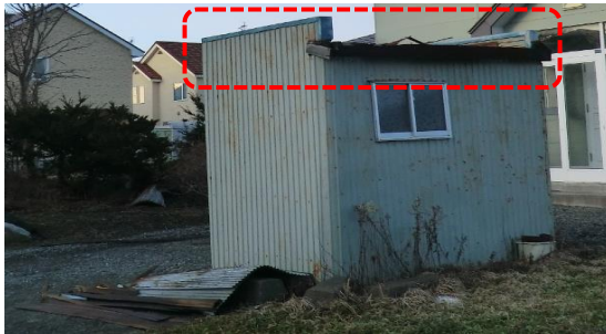
⑪物置のトタンの飛散
