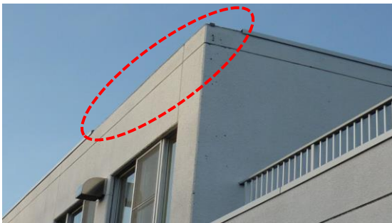
③老人ホームのアルミ建材の飛散 (屋上アルミ建材防水カバーが北に約30m飛散した。)
