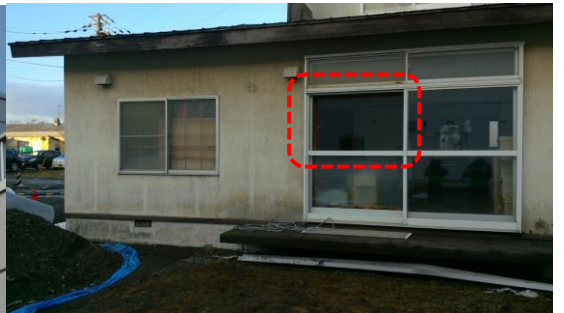
④老人ホームからの飛散物による窓ガラスの損壊
