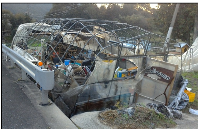
②倒壊したパイプハウス
