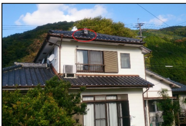
④屋根瓦がめくれた住家(提供:大村消防署)
