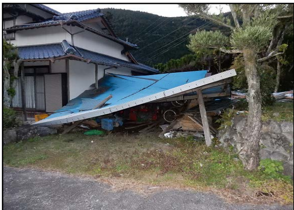
①倒壊した物置小屋
