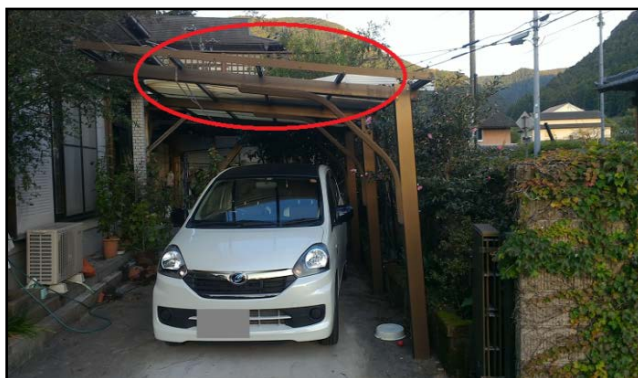
⑥破損したカーポートの屋根
