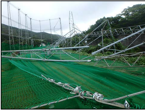
①ゴルフ練習場の鉄製支柱の倒壊 (撮影方向：北東)
