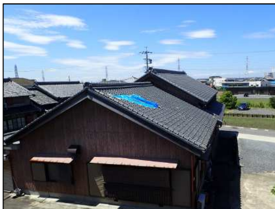
屋根瓦がめくれた住家 （ブルーシート部分） （北東から撮影）
