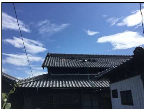
屋根瓦がめくれた住家 (北から撮影)
