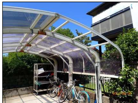
屋根パネルが破損したカーポート （北東から撮影）
