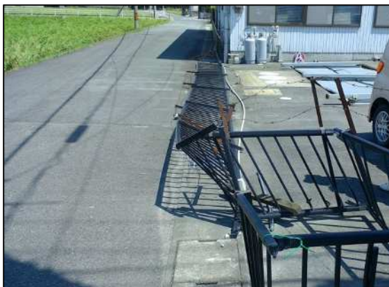
変形したフェンス （南から撮影）
