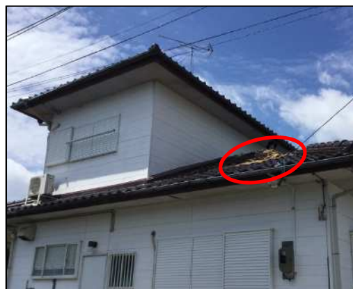
瓦屋根がめくれた住家 (北東から撮影)
