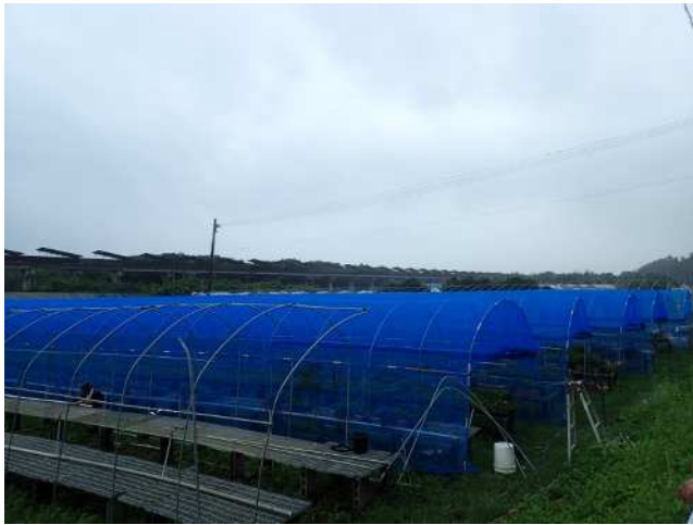
変形したビニールハウス(撮影方向:南東)
