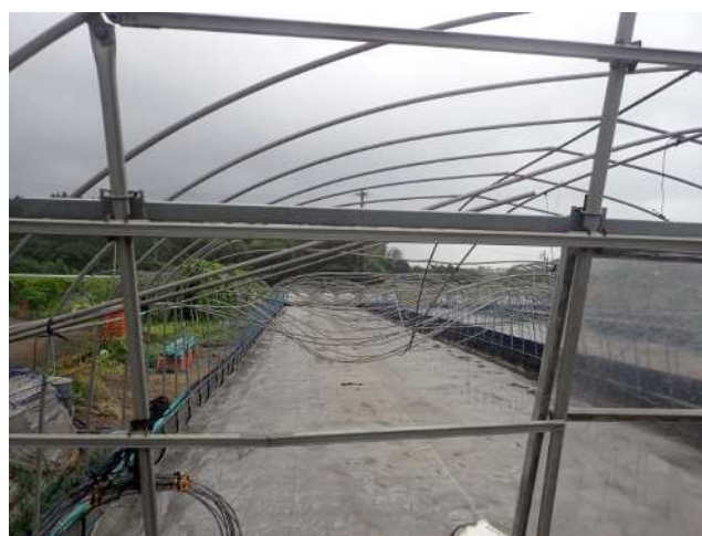
変形したビニールハウス(撮影方向:北)
