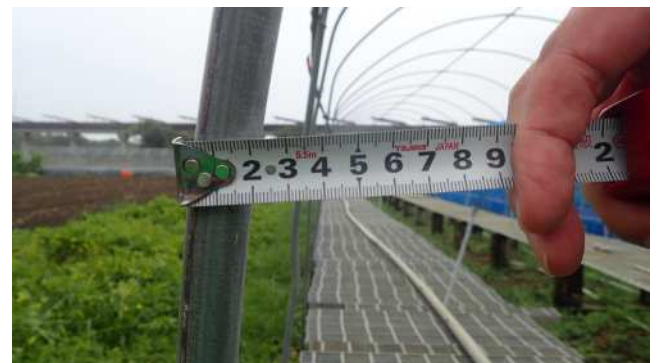
ビニールハウスの鋼管径は19mm(撮影方向:東)
