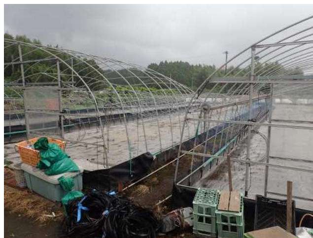
変形したビニールハウス(撮影方向:北西)
