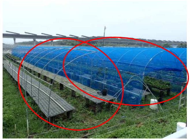
変形したビニールハウス(撮影方向:東南東) ビニールハウス2棟の赤線内で、 変形の被害があったが修復済
