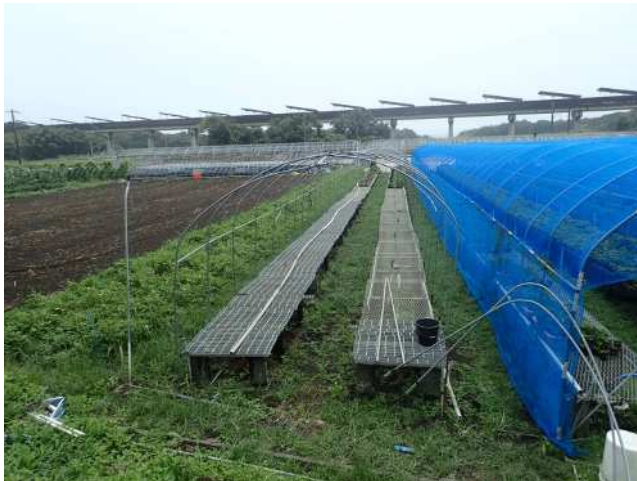
変形したビニールハウス(撮影方向:東)
