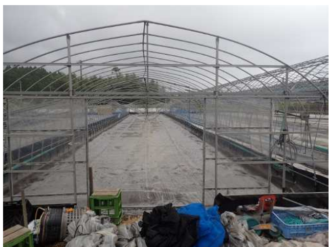
変形したビニールハウス(撮影方向:北)
