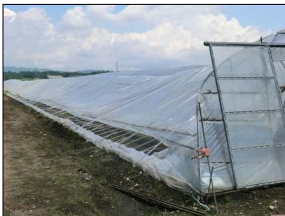
倒壊したビニールハウス (西から撮影)
