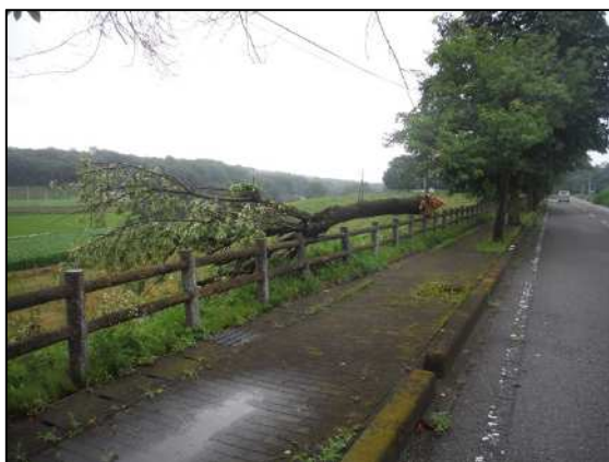
幹折れした樹木 (北西から撮影) (大田原市提供)
