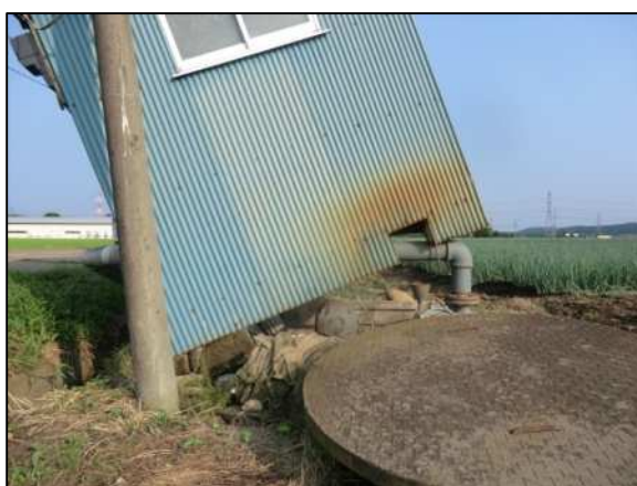
傾いたポンプ小屋 (北西から撮影)
