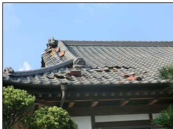
飛散した屋根瓦 (南西から撮影)
