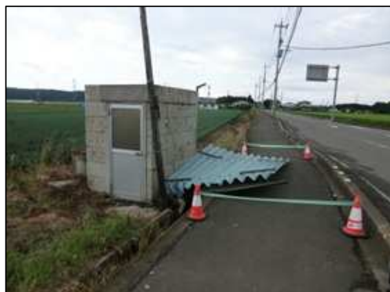
飛散したポンプ小屋の屋根 (北東から撮影) (大田原市提供)
