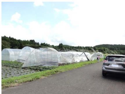
①-1 倒壊したハウス（撮影方向：南西）
