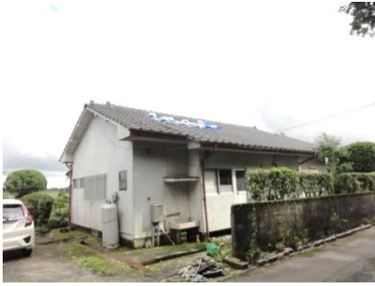
⑥ 屋根瓦が一部はがれた住家 (撮影方向：南)
