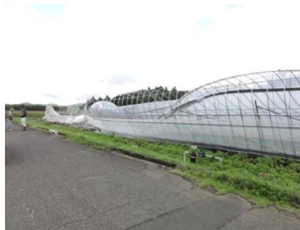
①-2 倒壊したハウス（撮影方向：南東）
