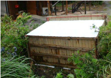
⑧ 転倒した倉庫 (撮影方向：北西)
