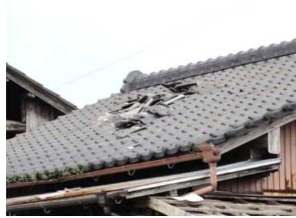
⑦ 屋根瓦が一部はがれた住家 (撮影方向：南東)
