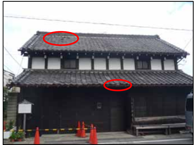
屋根瓦がめくれた住家（神明） （東から撮影、草加市提供）
