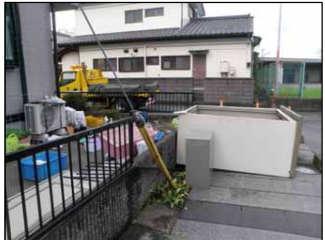
倒壊した倉庫、損壊したフェンス（松江） （東から撮影、草加市提供）
