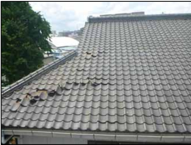
屋根瓦がめくれた店舗（神明） （南から撮影）
