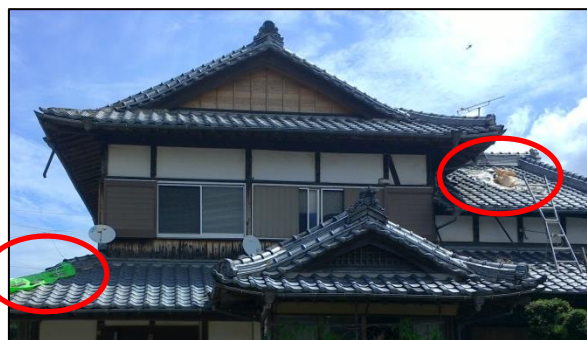
⑤屋根瓦が飛散した住家（撮影方向：北）
