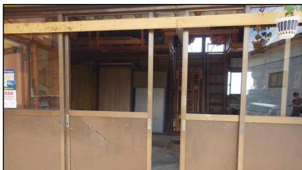
⑥ガラスが破損した扉（撮影方向：北）
