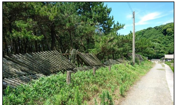
②倒壊した木造フェンス（撮影方向：西）
