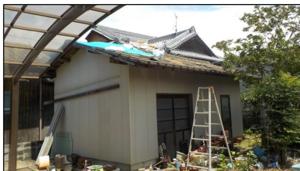
④瓦が飛散した物置（撮影方向：北）
