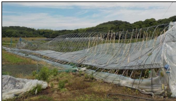
⑧倒壊したビニールハウス (撮影方向: 北)
