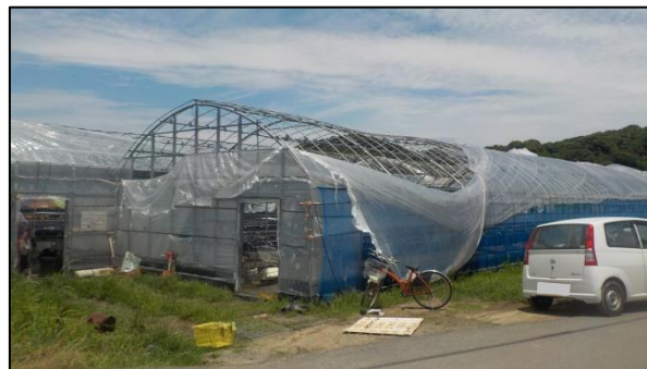
⑨被覆材がはく離したビニールハウス (撮影方向: 北西)
