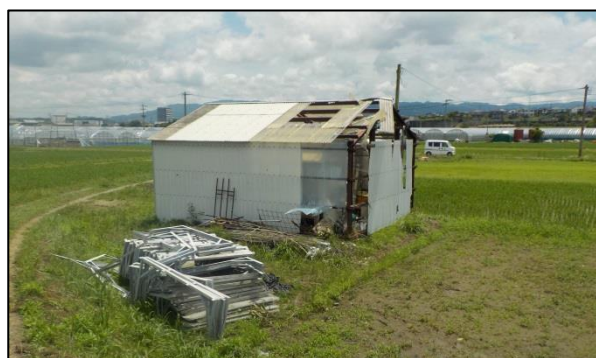
⑩めくれたトタン屋根（撮影方向：東）
