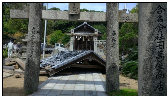
⑦倒壊した神社施設（撮影方向：北西）
