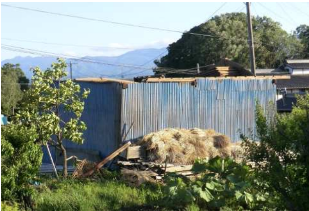
屋根が飛散した物置 (北東から撮影)
