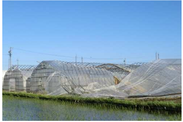
一部損壊したビニルハウス (北西から撮影)
