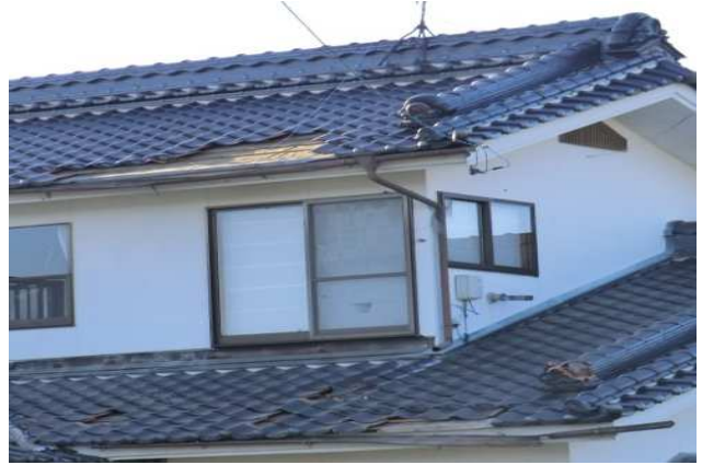
飛散物で損壊した住家 (南東から撮影)
