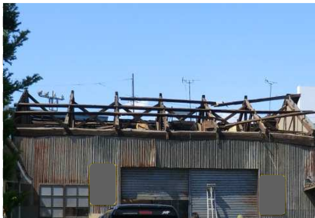
屋根が損壊した倉庫 (南から撮影)
