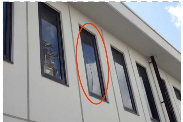
飛散物で割れた窓ガラス (北西から撮影)
