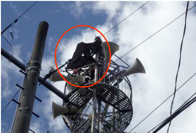
鉄塔に絡んだ飛散物 (北東から撮影)
