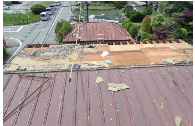
屋根が飛散した住家 (北から撮影)
