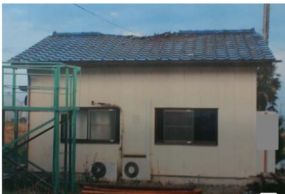
⑤ 損壊した倉庫（屋根） （南から撮影）
