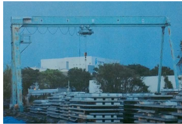
⑥ 移動したクレーン （西から撮影）
