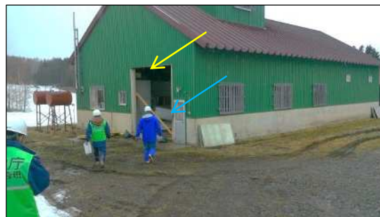
鉄筋造倉庫のシャッター飛散 (黄色矢印で指す開口部全面にあったシャッターが、倉庫内の青矢印部に飛散した。)
