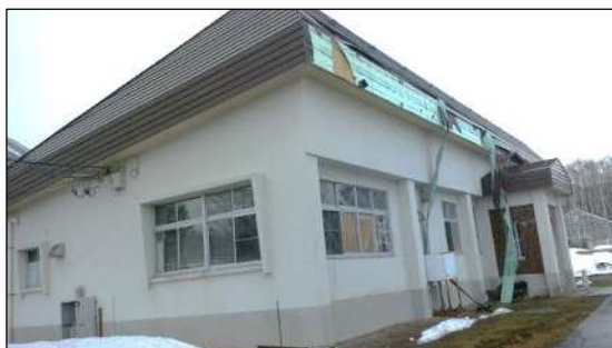
鉄骨系店舗の屋根材のはく離
