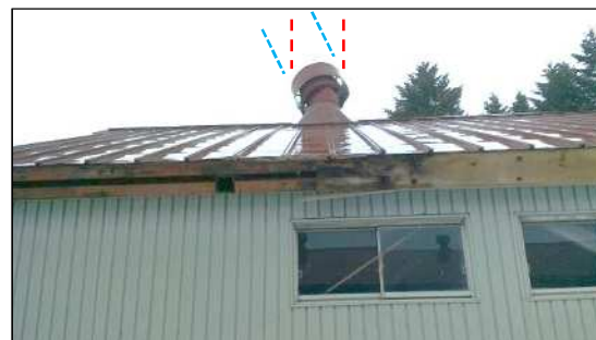
倉庫の煙突折損 (赤色破線の方に設置されていた煙突が、水色破線の方向に折れ曲がった。)
