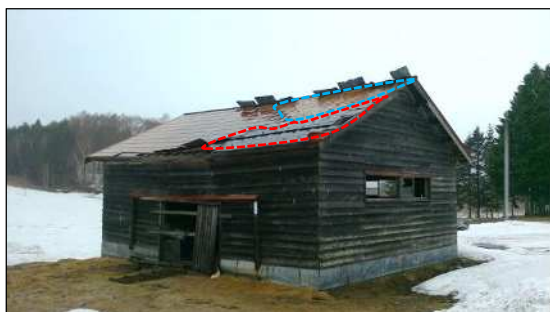
木造非住家(倉庫)の屋根材はく離 (水色破線で示した部分が剥離した。 赤色破線で示した部分は元から剥がれていた。)
