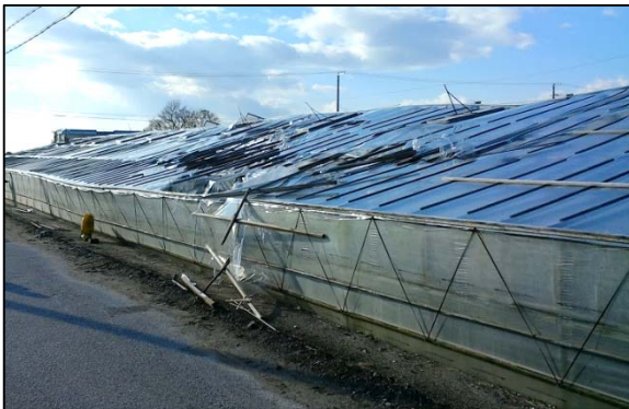
① 構成部材が損傷したプラスチックハウス
