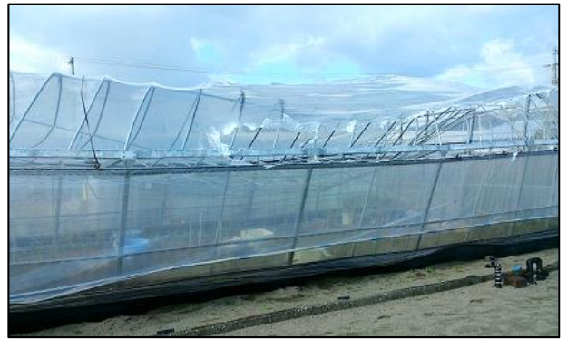
② 鋼管が変形したパイプハウス
