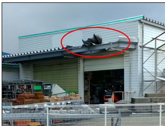
庇に被害があった施設 【南西方向から撮影】
