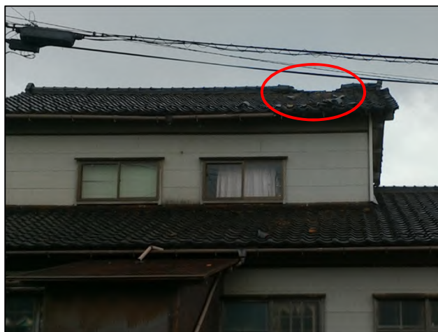
屋根瓦のめくれや落下があった住家 【北東方向から撮影】
