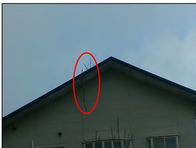
テレビアンテナの傾倒があった住家 【南東方向から撮影】
