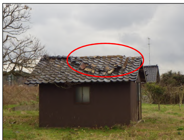
屋根瓦のめくれや落下があった作業小屋 【北東方向から撮影】
