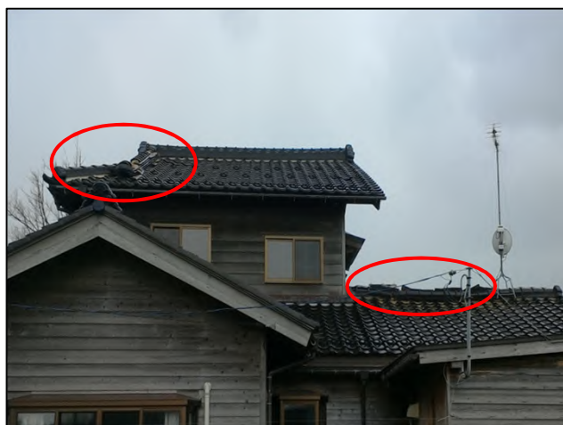
屋根瓦のめくれや落下があった住家 【北方向から撮影】
