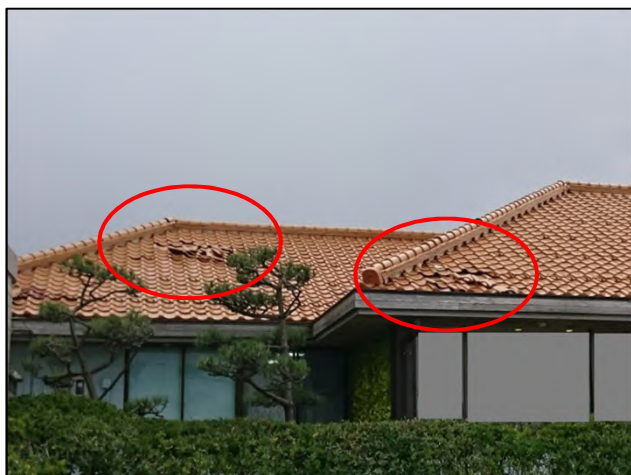
屋根瓦のめくれや落下があった施設 【北西方向から撮影】
