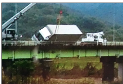
横転したトラック (撮影方向:北西) (現場近くの聞き取り調査した方の撮影)
