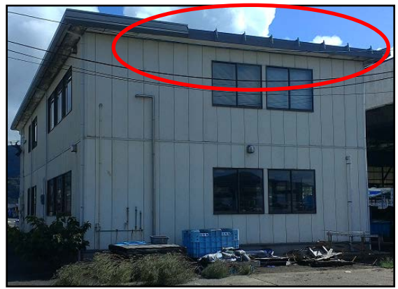
④屋根ふき材が飛散したプレハブの事務所(撮影方向:南東)
