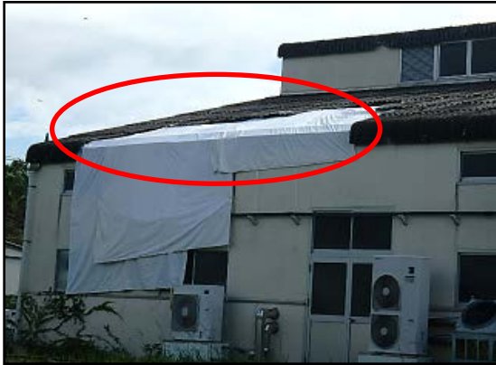
①屋根ふき材が飛散した倉庫(撮影方向:北東)
