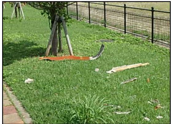
②飛散した屋根ふき材(撮影方向:北東)
