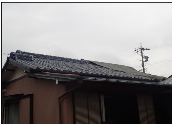
屋根瓦がめくれた住家 （南から撮影）
