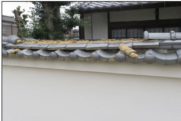
⑤ 瓦がめくれた塀
