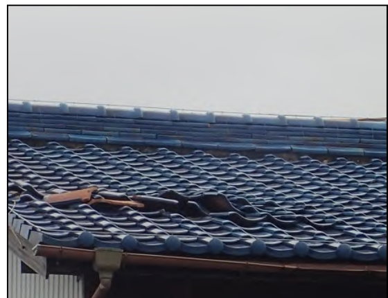
屋根瓦がめくれた住家 （北から撮影）
