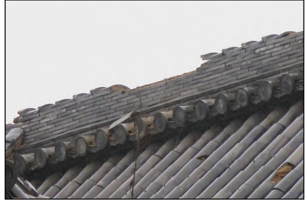
② 屋根瓦がめくれた寺院
