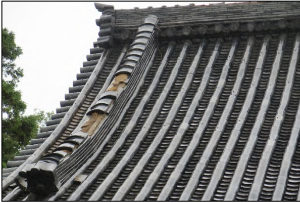
① 屋根瓦がめくれた寺院
