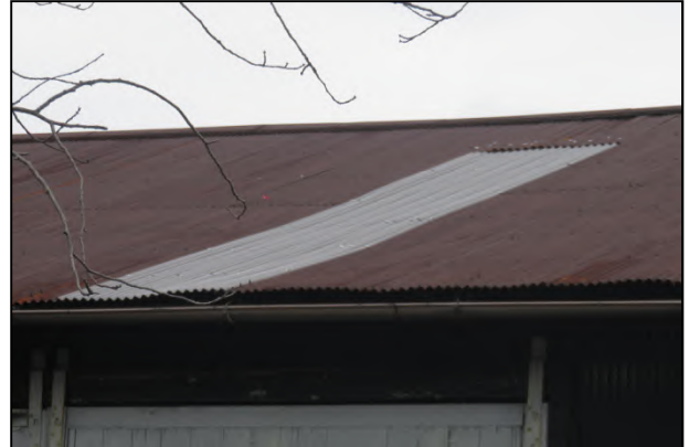
④ 屋根のトタンがめくれた倉庫
