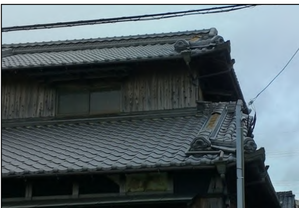
屋根瓦がめくれた住家 (北から撮影)
