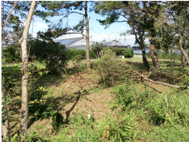
⑬枝折れした樹木(撮影方向:北)
