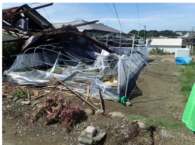
⑨倒壊したビニールハウス(撮影方向:西)
