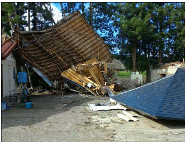
③屋根がはく離した作業小屋(南から撮影)
