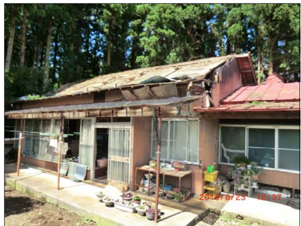
⑥トタン屋根がはく離した住家(南から撮影)
