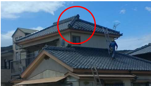
屋根瓦が浮いた住家 (東から撮影)
