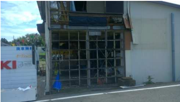
外壁がめくれた店舗 (北から撮影)
