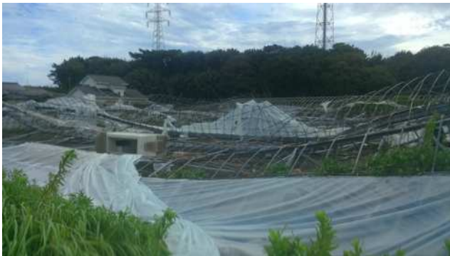
倒壊したパイプハウス (北東から撮影)
