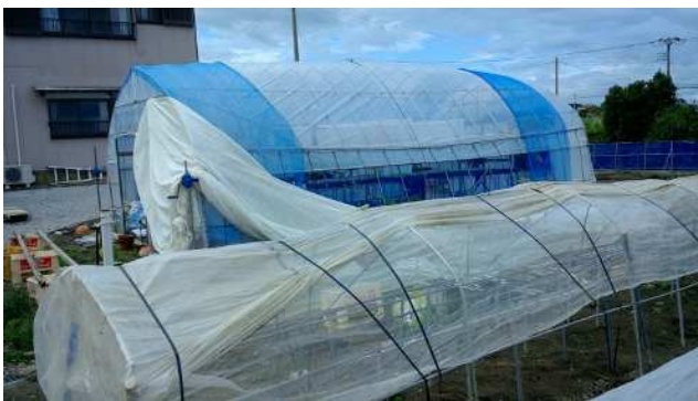
ビニールがめくれたパイプハウス (南から撮影)
