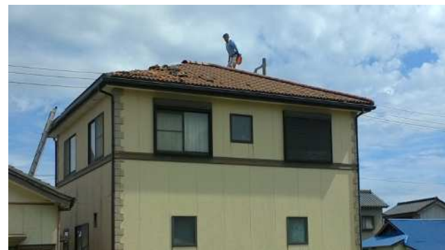
屋根瓦がめくれた住家 (北から撮影)
