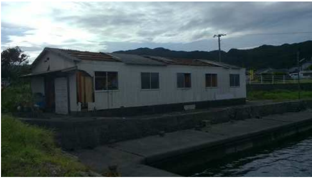
屋根のトタンが飛散した非住家 (東から撮影)
