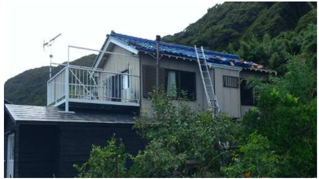
屋根瓦がめくれた住家 (北東から撮影)
