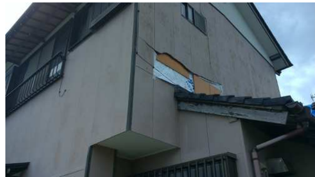
外壁がはがれた住家 (北東から撮影)
