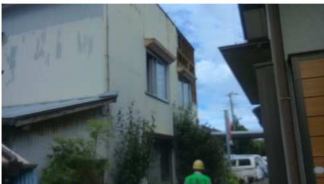
外壁がめくれた住家 (北西から撮影)
