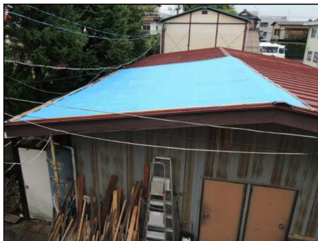
屋根が飛散した倉庫（新座市） （南西から撮影）
