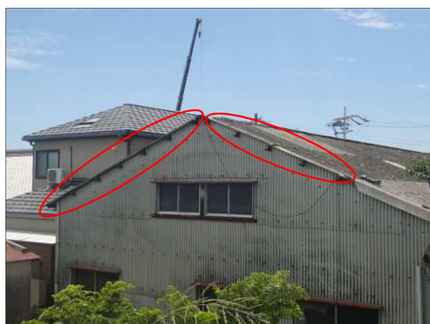
屋根(スレート)がめくれた工場 (北から撮影)
