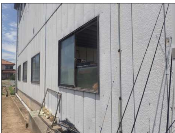
窓が外れて落下した住宅 (北東から撮影)
