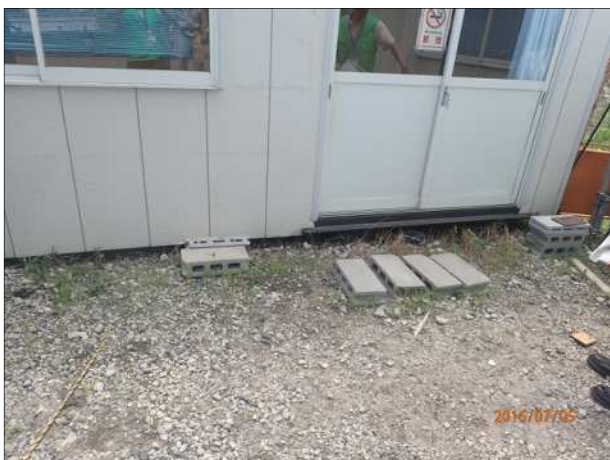
移動した仮設事務所 (西北西から撮影)
