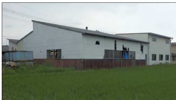
④外壁等が破損した工場(北西側から撮影)
