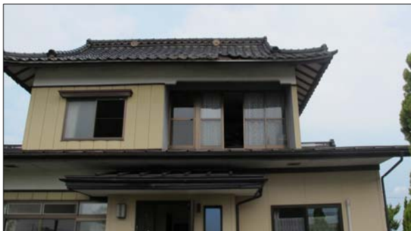
①屋根瓦が飛散した住家(南側から撮影)
