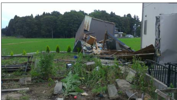
⑤転倒したプレハブ小屋(西側から撮影)
