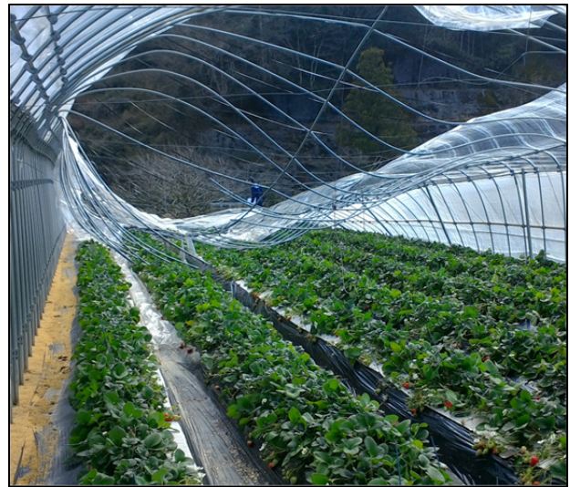
② 骨組が変形した農業用ハウス
