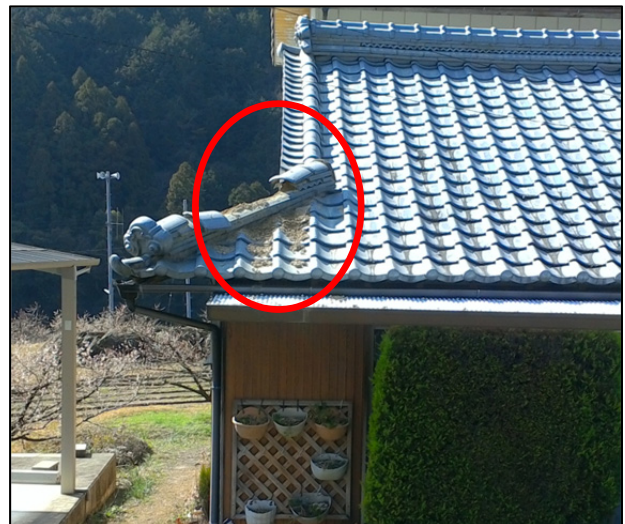
④ 屋根瓦が落下した住家
