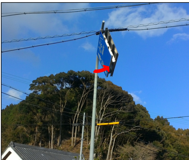
⑤ 傾斜した道路交通標識板
