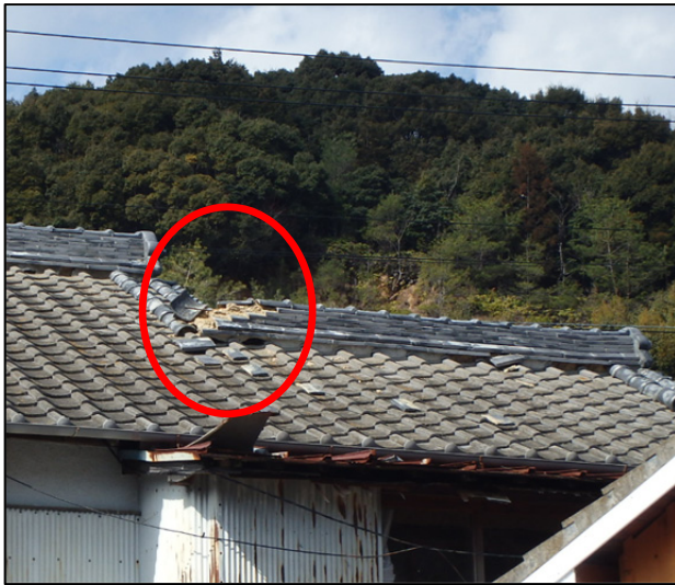
① 屋根瓦がめくれた住家
