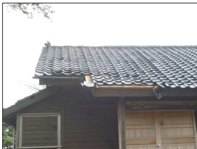
屋根瓦が落下した神社 【南西方向から撮影】 (志賀町役場提供)
