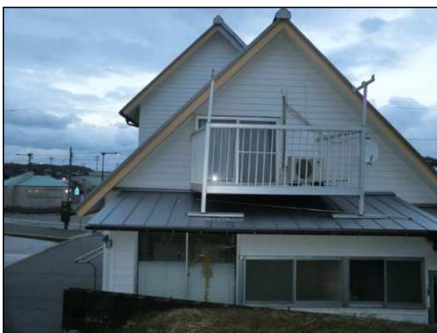
ベランダが横にずれた住家 【南西方向から撮影】
