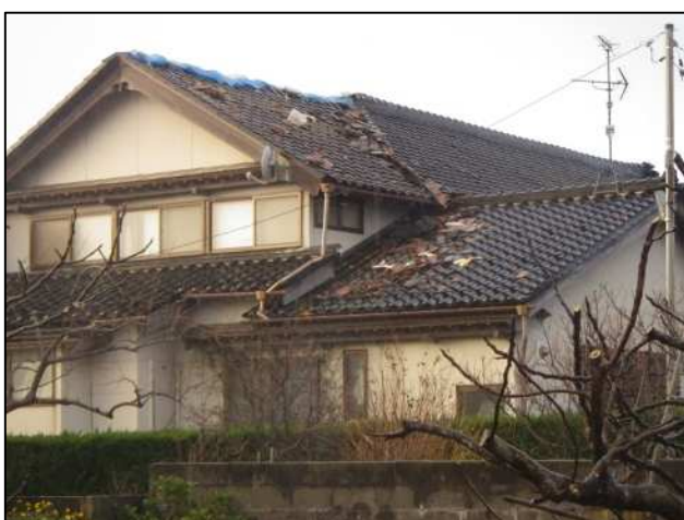
屋根瓦のめくれや落下があった住家 【南東方向から撮影】
