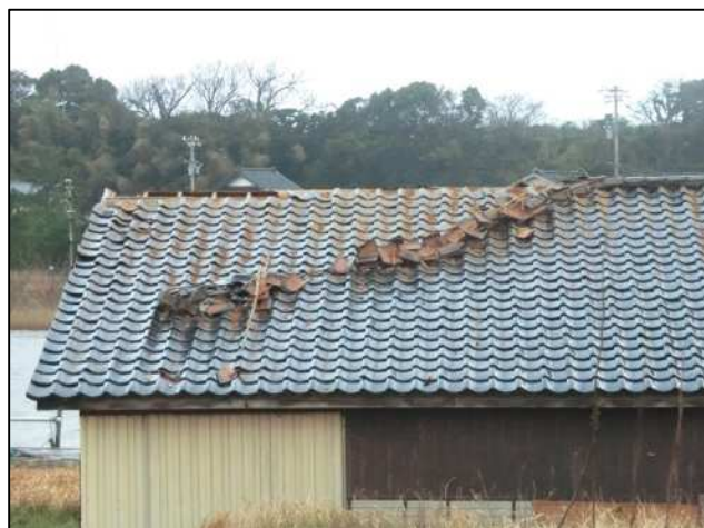
屋根瓦のめくれや落下があった倉庫 【南東方向から撮影】
