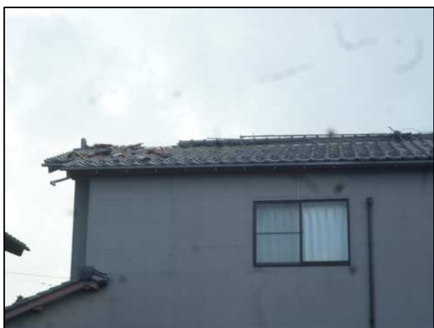
屋根瓦のめくれや落下があった住家 【東方向から撮影】(志賀町役場提供)
