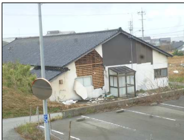
外壁が剥がれ落下した倉庫 【北東方向から撮影】(志賀町役場提供)
