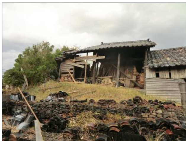
外壁が飛ばされた納屋 【南方向から撮影】
