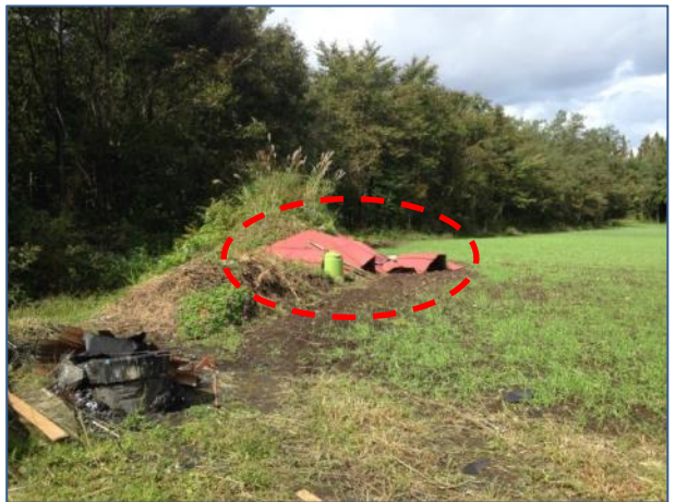
⑫ 北西に約 20m 飛ばされた屋根のトタン(南から撮影)
