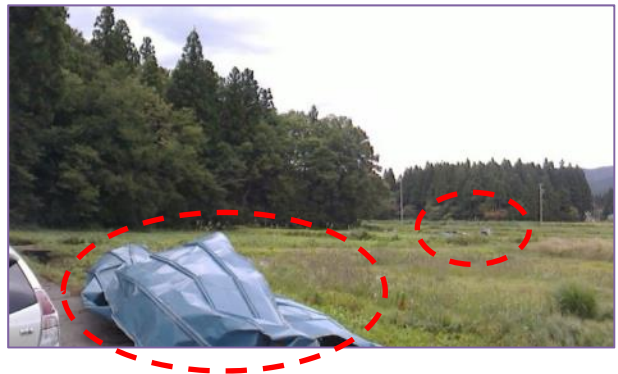
④ 非住家(③の赤点線)から北東に飛ばされ た屋根のトタン (南西から撮影)
