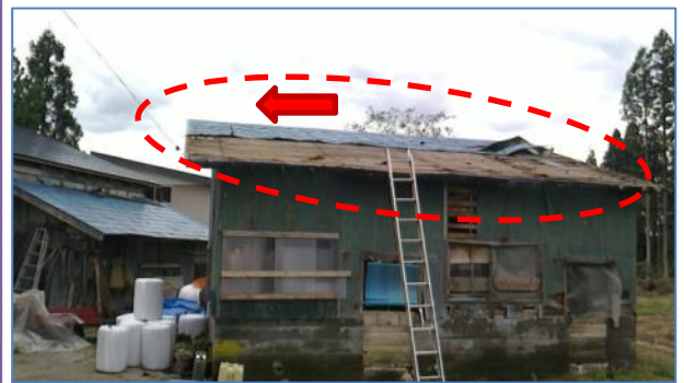
⑥ 屋根のトタンが東側に飛んだ畜舎 (北から撮影)
