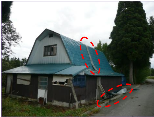
⑨ 屋根のトタンが東に飛ばされた非住家(南南東から撮影)
