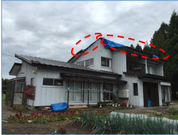
⑦ 屋根のトタンと屋根材の一部が北東に飛ばされた住家(南西から撮影)
