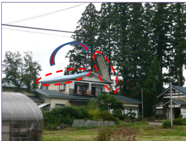
⑪ 屋根のトタンが北東に飛び、スギの木に引っかけた住家(南西から撮影)
