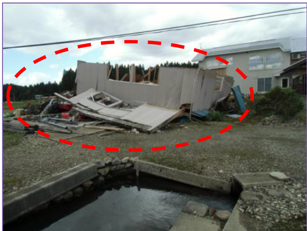
⑤ 倒壊した非住家 (南東から撮影)
