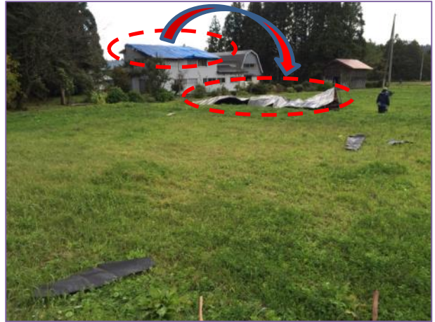
⑧ 屋根のトタンが北東に飛ばされた住家(北東から撮影)
