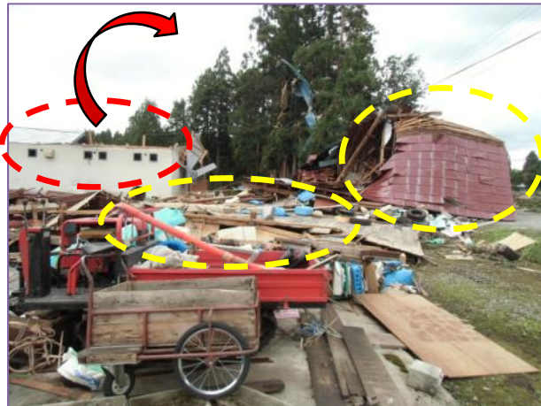
③ 倒壊した複数の非住家 [黄点線] 屋根のトタンが北東に飛ばされた非住家 [赤点線→④] (南から撮影)
