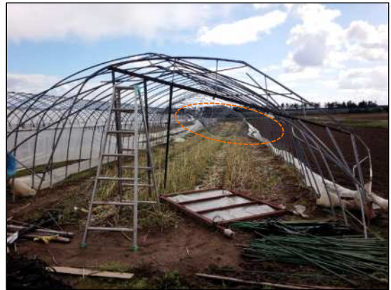
倒壊したビニールハウス
