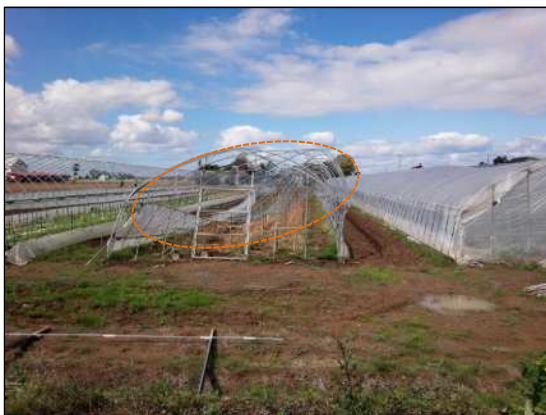
倒壊したビニールハウス
