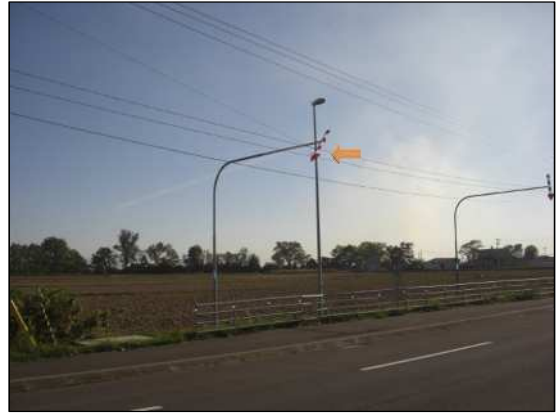
北東方向に傾斜した道路標識(写真右端の標識が正常な状態)
