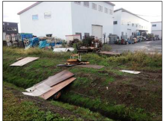
東方向に飛散した資材(ベニヤ板など)
