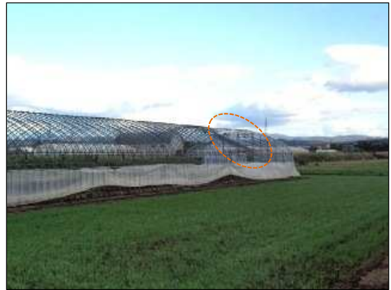
一部損壊したビニールハウス
