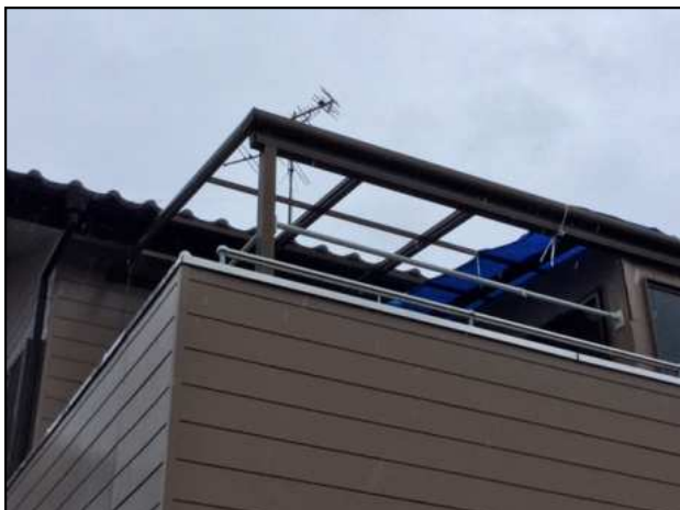
ベランダの屋根が飛散した住家 (南東から撮影)
