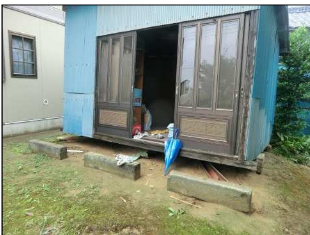
ずれた物置 (南東から撮影)
