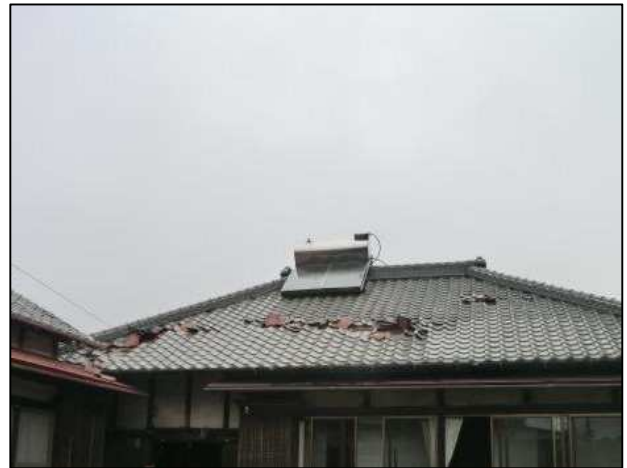
屋根瓦がめくれた住家 (南から撮影)
