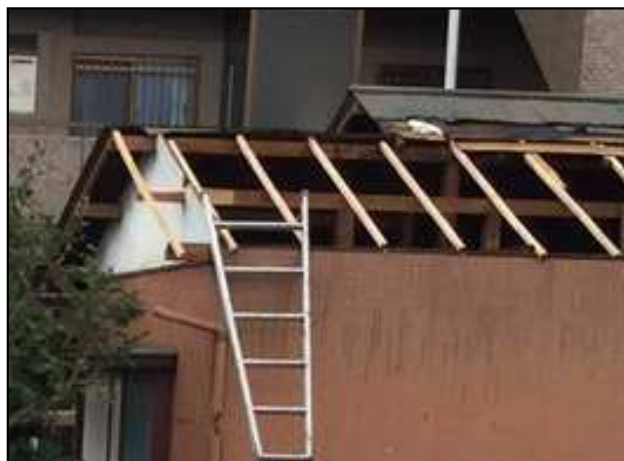
屋根のトタンがはがれた住家 (北から撮影)
