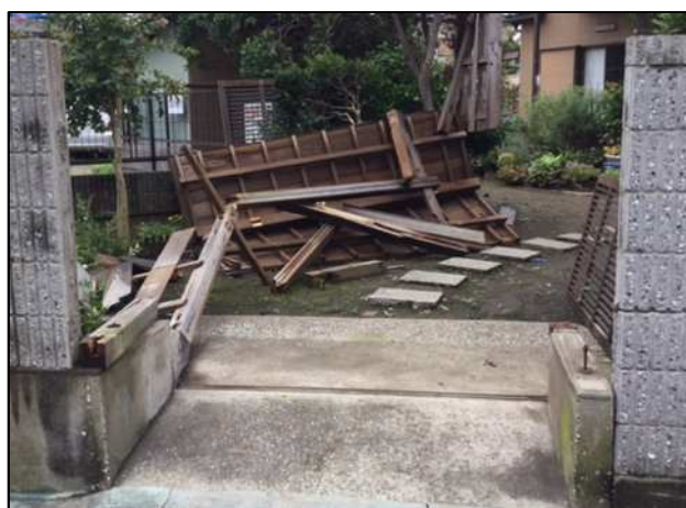
飛散した門扉 (南東から撮影)
