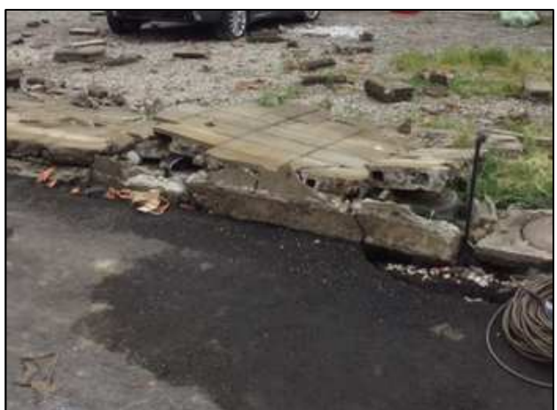
倒れたブロック塀 (北東から撮影)
