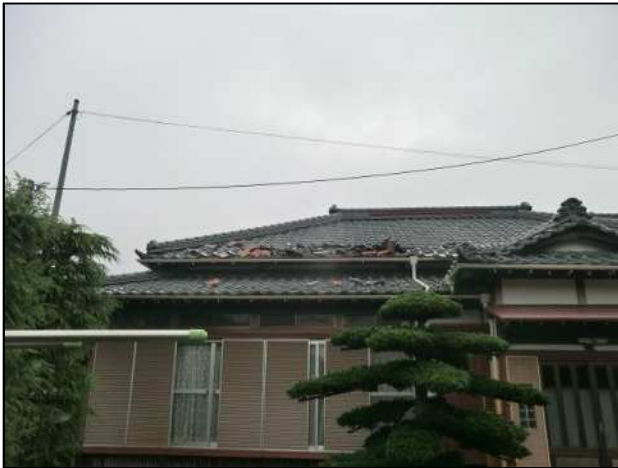
屋根瓦がめくれた住家 (南東から撮影)
