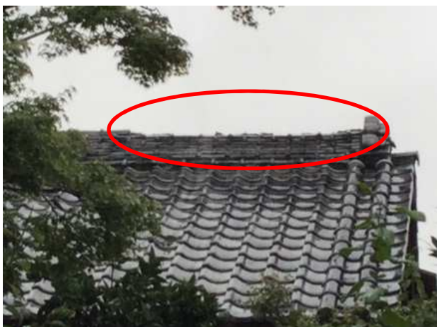
屋根瓦がめくれた住家 (西から撮影)
