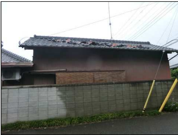
屋根瓦がめくれた非住家 (西から撮影)
