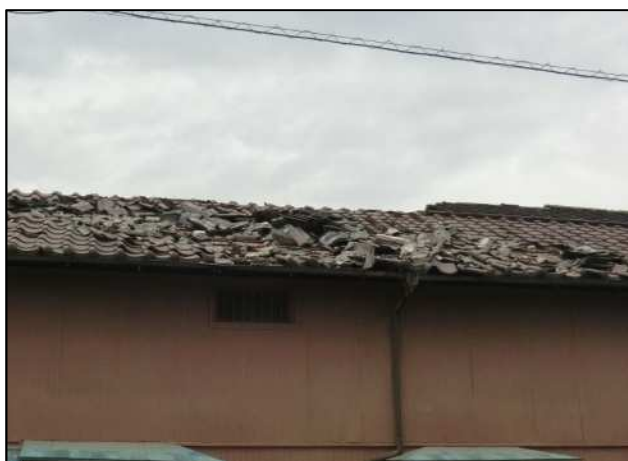
屋根瓦がめくれた住家 (南から撮影)
