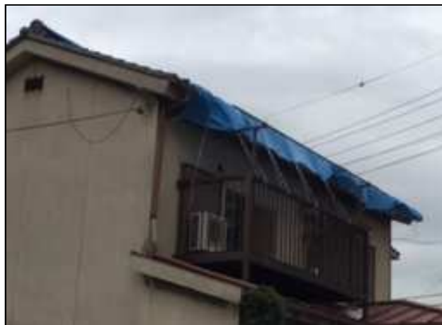
屋根瓦が飛散した住家 (南西から撮影)
