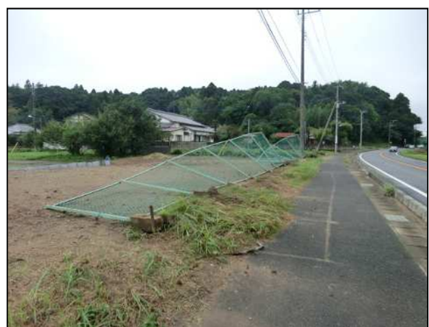
倒れたフェンス (北東から撮影)
