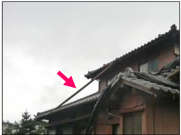
雨どいが外れて垂れ下がった住家 (北西から撮影)
