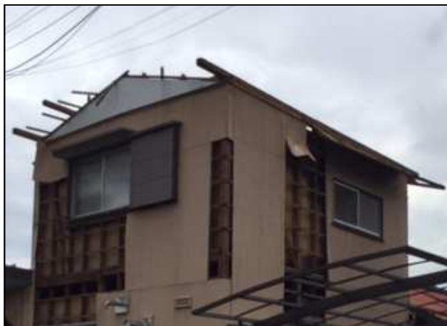
屋根が飛散し、壁がはがれた住家 (北東から撮影) 被害としてはF2相当だが、周囲の状況からF1 として評定した
