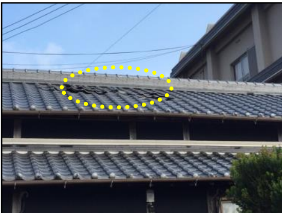
③ 屋根瓦が20枚程度めくれて落下した住家(修復途中)
