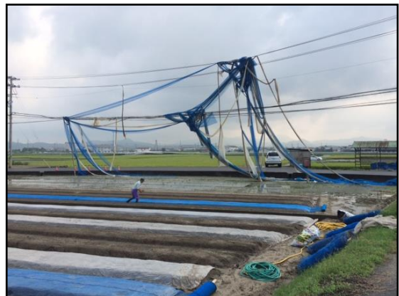
④ 畑から飛散して電線に巻きついた農業用シート
