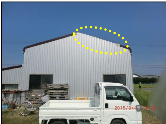
⑦ スレート屋根が一部めくれた倉庫
