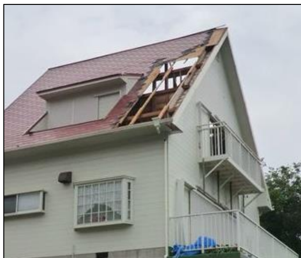
④ 屋根の一部が飛散した住家
