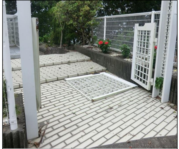
⑥ 破損した門扉
