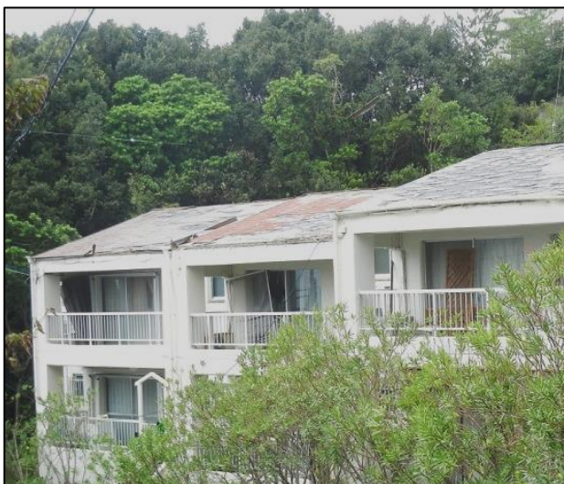
③ 屋根瓦 (スレート) が飛散した住家
