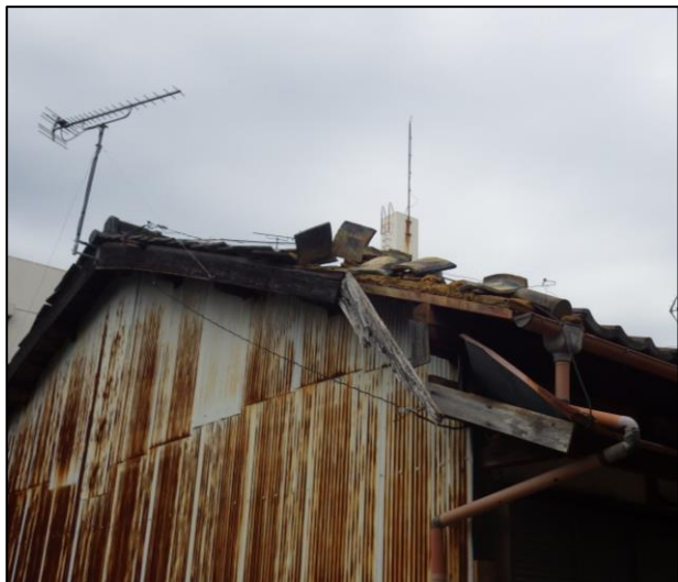
① 屋根瓦がめくれた住家
