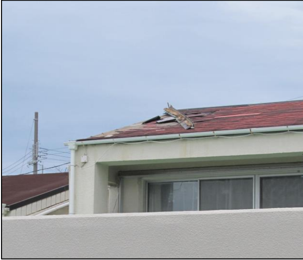
⑤ 屋根瓦（スレート）がめくれた住家
