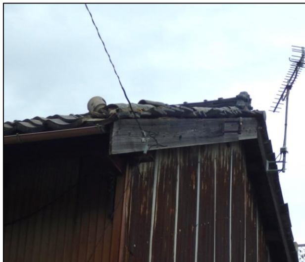
② 屋根瓦がめくれた住家
