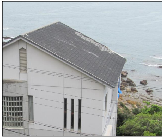
⑧ 屋根瓦（スレート）が飛散した住家
